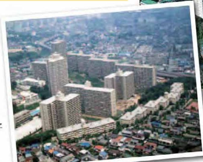
竣工当時の様子
