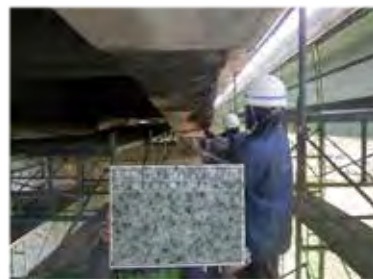
修繕の様子(断面修復)
