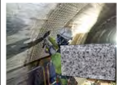
修繕の様子(剥落対策)
