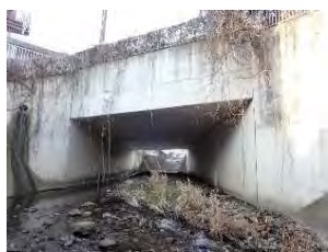
▲水路ボックス
