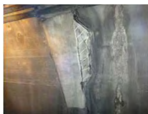
▲トンネル目地部
