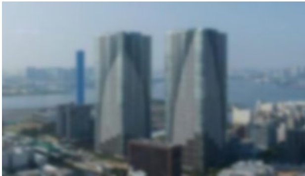
2棟の世帯数/約2,800戸 日/約300個～400個の宅配荷物到着
