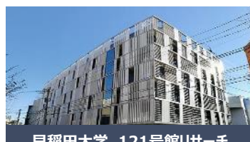
早稲田大学 121号館リサーチ イノベーションセンター (2021年1月導入)
