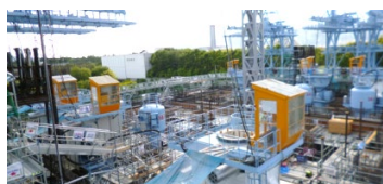
処理施設の工事
