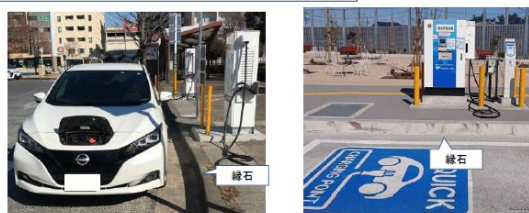
車道と急速充電設備との間に緑石を設けている事例
