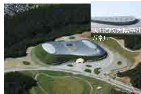
供給型の太陽光発電施設の例（屋内型運動施設の屋根に設置）
