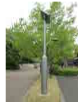
独立型の太陽光発電による照明灯の例
