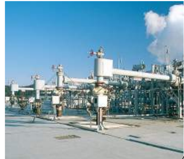
傾斜掘削基地（例）
