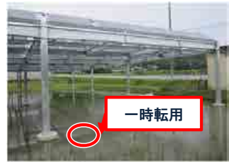
▲ 営農型太陽光発電設備の例
